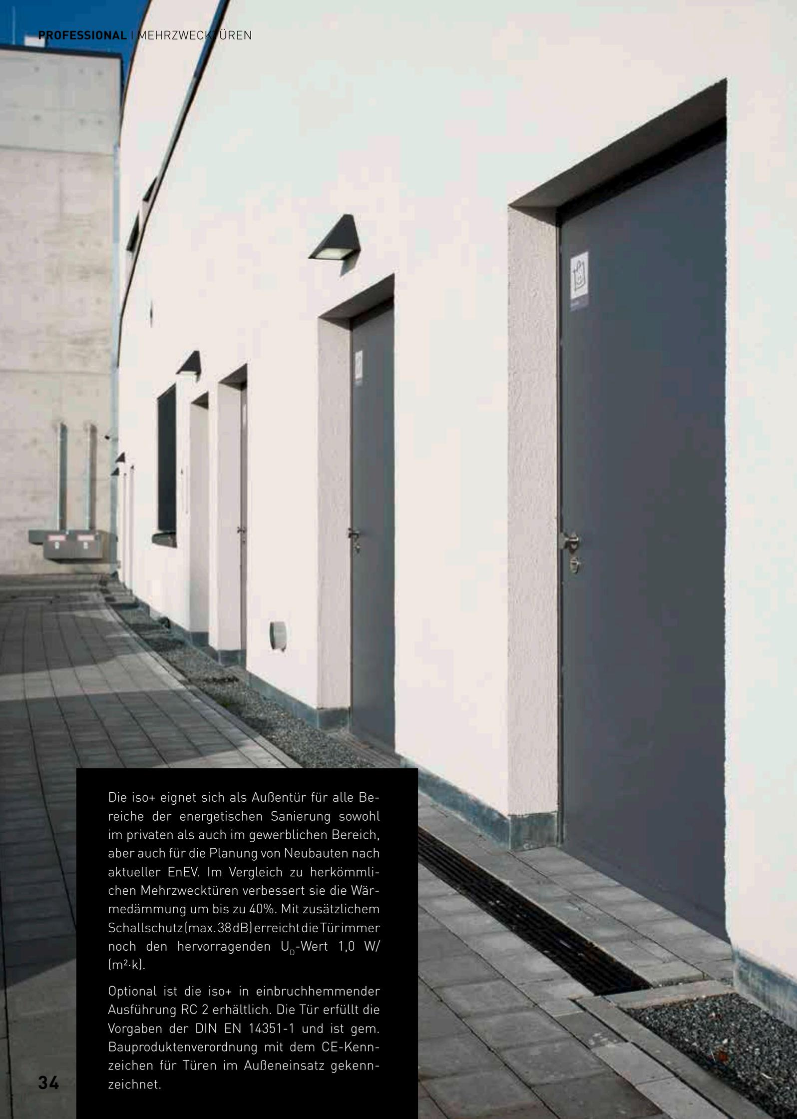
Die iso+ eignet sich als Außentür für alle Bereiche der energetischen Sanierung sowohl im privaten als auch im gewerblichen Bereich, aber auch für die Planung von Neubauten nach aktueller EnEV. Im Vergleich zu herkömmlichen Mehrzwecktüren verbessert sie die Wärmedämmung um bis zu 40%. Mit zusätzlichem Schallschutz (max. 38 dB) erreicht die Tür immer noch den hervorragenden  $U_D$ -Wert 1,0 W/(m<sup>2</sup>·K).
