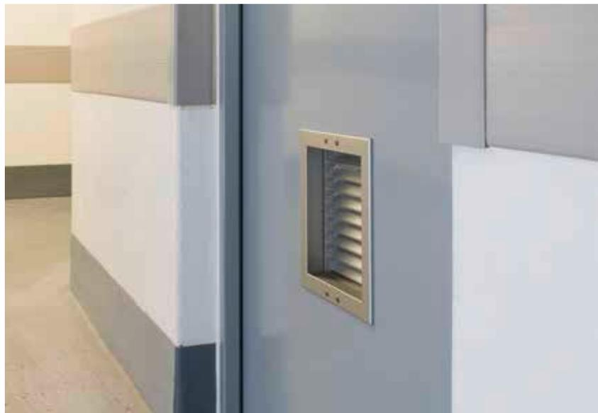
Mehrzwecktür mit Lüftungsgitter
