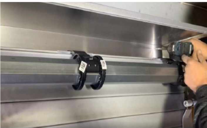
Kastenvorderseite am Sturz verschrauben/verdübeln
