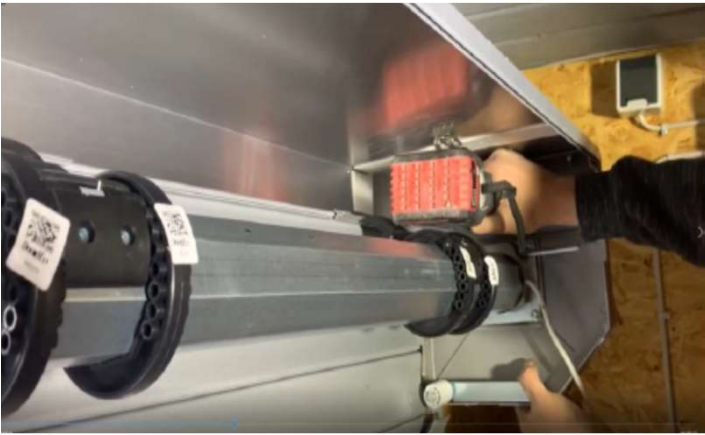
Konsolen verschrauben/verdübeln
