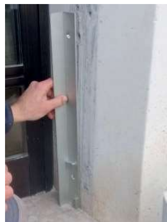
12 Die Eckwinkel anbringen, indem Sie diese zuerst am Boden aufstellen.
