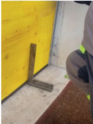
4 Die Wasserschutzwand im rechten Winkel zur Bodenfläche ausrichten.
