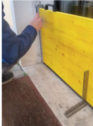
5 Die Position der Eckwinkel markieren.
