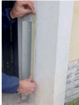
17 Mit Kreppband die Wand entlang des Winkels mit einem einen Spalt von ca. 5mm abkleben.
