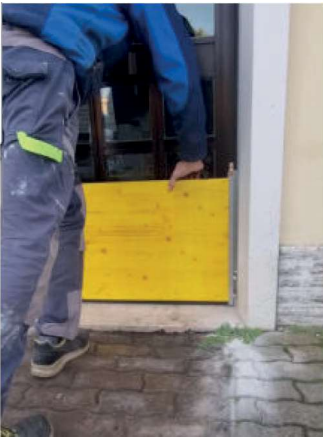
16 Die Montageposition der Wasserschutzwand prüfen.
