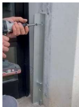
13 Die Eckwinkel an der Wand anschrauben.
