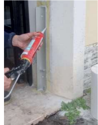
18 Mit Silikon die Ecke des Winkels abdichten
