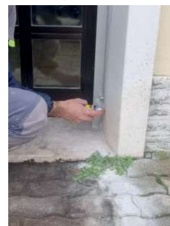
15 Die Einrastprofile an den Eckwinkeln einlöten.
