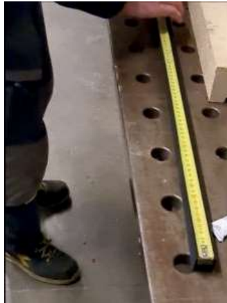
20 Schneiden Sie die Bodendichtung 25x25 mm zu. Gemessene Länge +5 mm
