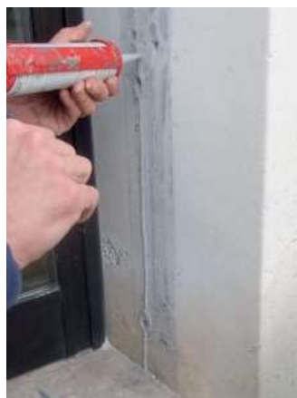
10 Im Bereich der Montagefläche Silikon auftragen
