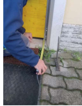
3 Die Wasserschutzwand in der gewünschten Lage positionieren.
