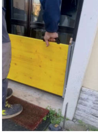
2 Die Wasserschutzwand in die Öffnung einsetzen.
