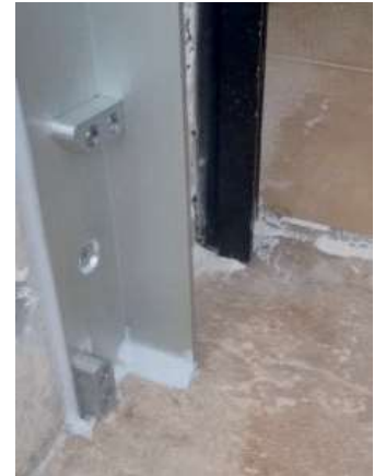
21 Das Ergebnis sollte eine Silikonraupe von 10x10 mm sein.
