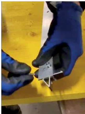
5 Setzen Sie die Haken oben ein.
