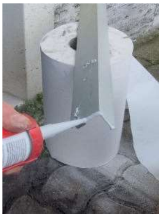
11 An der Rückseite der Nieten und dem Rand, der auf dem Boden aufsteht, mit Silikon abdichten.
