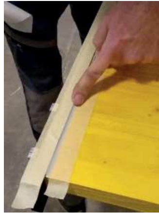
17 Die Silikonnaht glätten, um eine gleichmäßige Dichtung zu schaffen.
