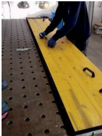
30 Messen Sie unten die Mitte der Wasserschutzwand.
