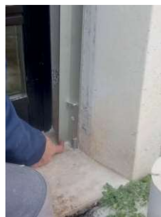
14 Das überschüssige Silikon entfernen.
