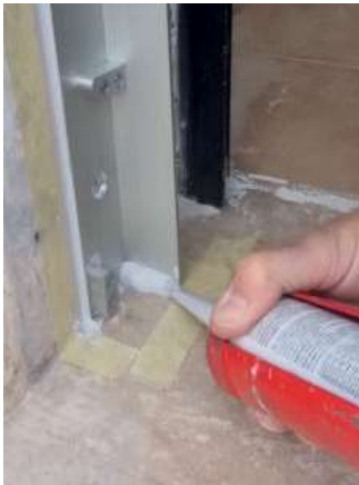
19 Eine Silikonraupe am Fuß des Eckwinkels setzen
