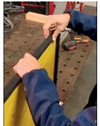
24 Nach dem Abziehen der Schutzfolie die Dichtung aufsetzen und sie gegen eine der beiden Seitendichtungen drücken. Anschließend die Dichtung aufkleben.
