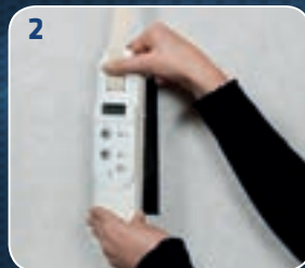
2 Elektrischen Gurtantrieb montieren
